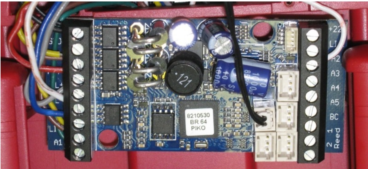
Bild-6: Neuverkabelung des Dekoders
